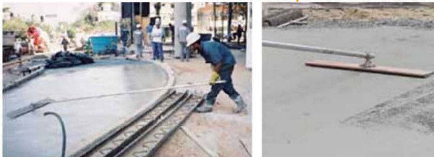
Figura 19 – Desempeno do concreto.
