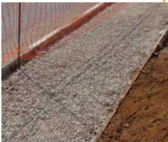
Figura 16 – Espalhamento da camada de Brita
