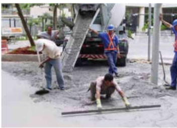
Figura 17 – Recebimento e espalhamento do concreto.
