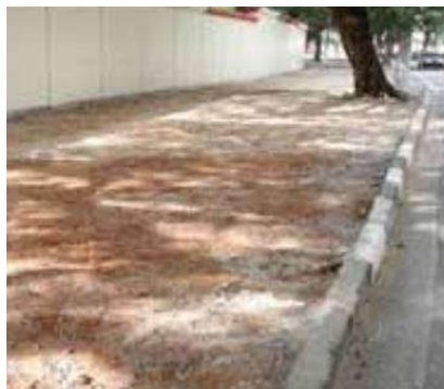
Figura 15 – Nivelamento e compactação do terreno
